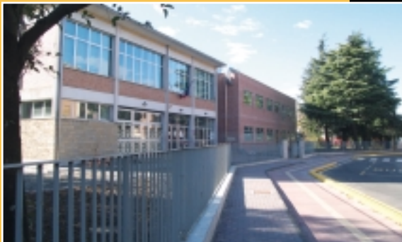
Pista ciclabile - Marciapiede in via Resistenza Importo lavori a base d'appalto € 80.000,00 (€ 90/m lineare)
